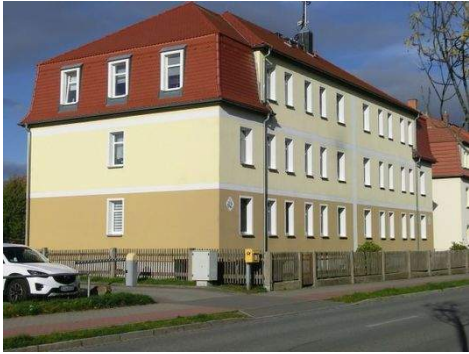
Ansicht des Mehfamilienhauses
