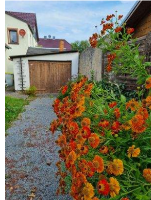
Garage mit Anbau
