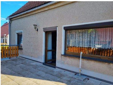
vom Wohnbereich aus begehbar in Südlage
