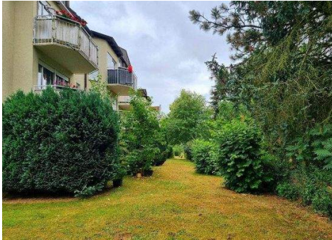
Rückseite des Wohnhauses
