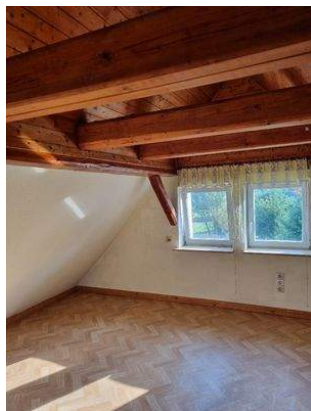
Raum im Dachgeschoss
