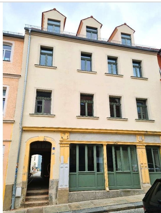
Hausansicht in Bauphase
