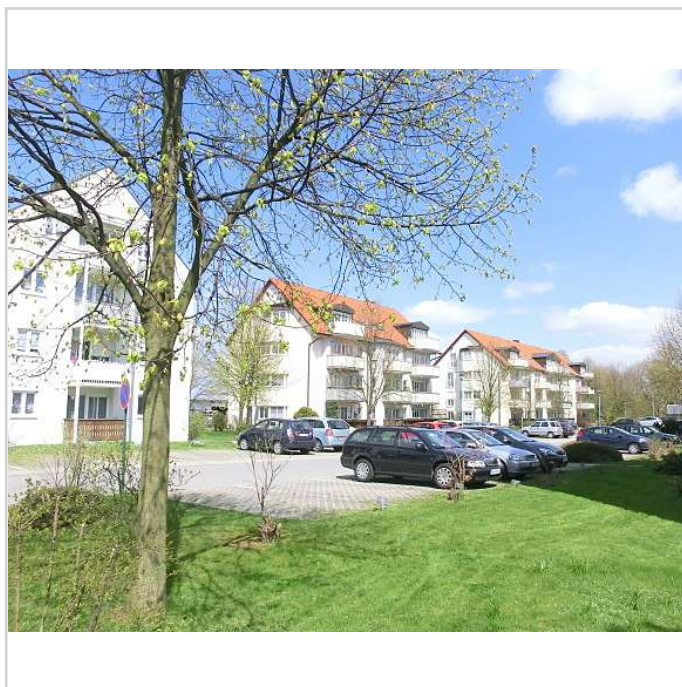
Blick in die Wohnanlage
