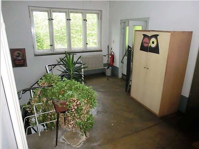
Flur im OG
