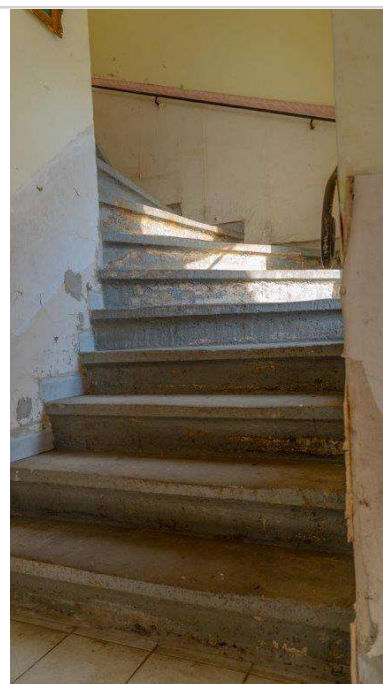
massive Treppe zum OG
