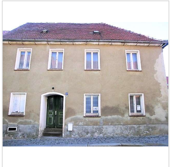
Ansicht von der Grunagasse
