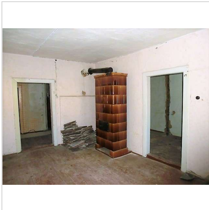
Raum im OG
